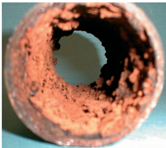
Foto 2. Corrosión en una tubería
