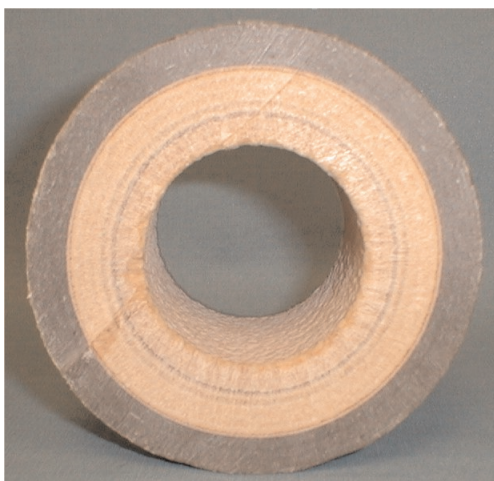
Foto 1. Tubería de agua fría con incrustaciones calcáreas
